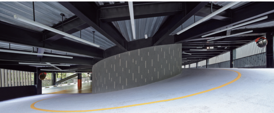
車道以不落柱的方式設計，並且以三度曲線的結構梁系統呈現。
