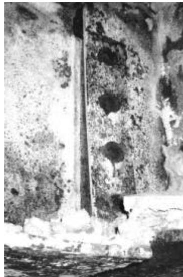
【照片四】小樑剪力螺栓掉落
