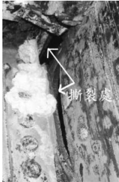
【照片三】柱面鋼板與樑上翼緣開裂
