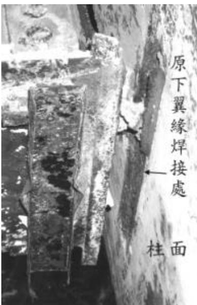
【照片二】大樑下翼緣焊接點破壞
