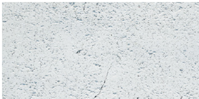
白の裂痕板 蚵灰、爐石、蚵殼
